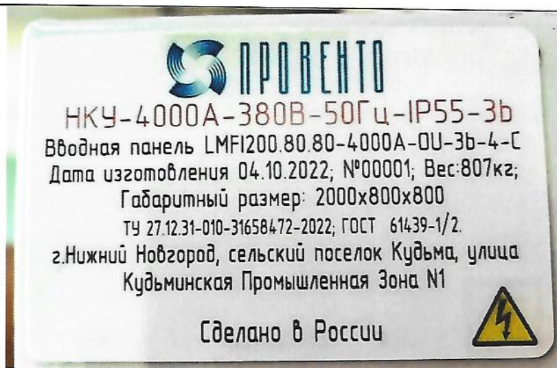
Рис.8.2. Маркировочная табличка панели ввода LMF1 200.80.80-4000A-OU-3b-4-C
