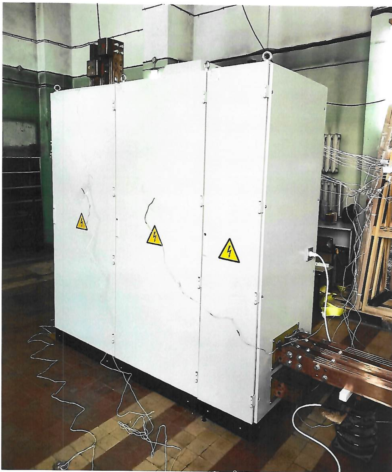
Рис.8.1. Внешний вид НКУ-4000А-380В-50Гц-IP55-3б
