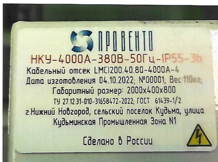
Рис.8.4. Маркировочная табличка кабельного отсека LMC1200.40.80-4000A-4
