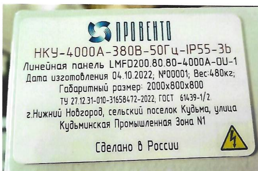
Рис.8.3. Маркировочная табличка линейной панели LMFD 200.80.80-4000A-OU-1
